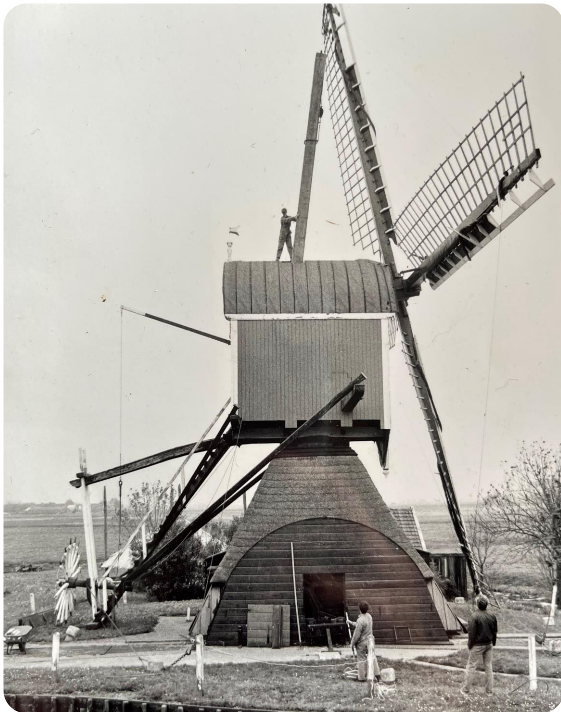
Steken van een nieuwe koningsspil bij de Vrouw-Vennemolen te Oud-Ade, door molenmakerij Van Beek uit Rijsaterwoude, 1984. Op de kap Willem Waltman, op de grond, links Teun Waltman en rechts Arie Verhey. (Foto: Wim van Noort/Leidse Courant.)
