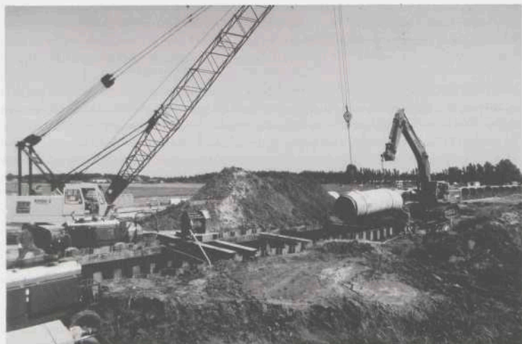
Afb. 1. Bergambacht-Wassenaar/Katwijk: rivierwatertransportleiding. Werkzaamheden in de leidingleuf. Foto N. Mulder.
