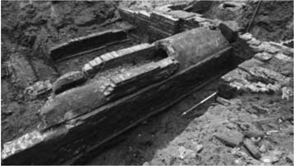
Afb. 12. Amsterdam * Paardenstraat 17. Gewelfde goot van het eind-19de-eeuwse beerput-afvoerstelsel aan de Paardenstraat, waarmee op de Amstel werd geloosd (foto: bureau Monumenten en Archeologie, W. Krook).
