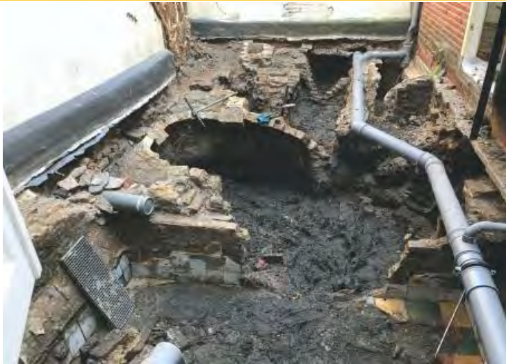
Overzicht van de funderingen onder de binnenplaats met vooraan de 18de-eeuwse kelder, daarachter de beerput, midden achteraan de waterput en rechts achteraan de waterkelder. (Foto: Archeologie Delft)
