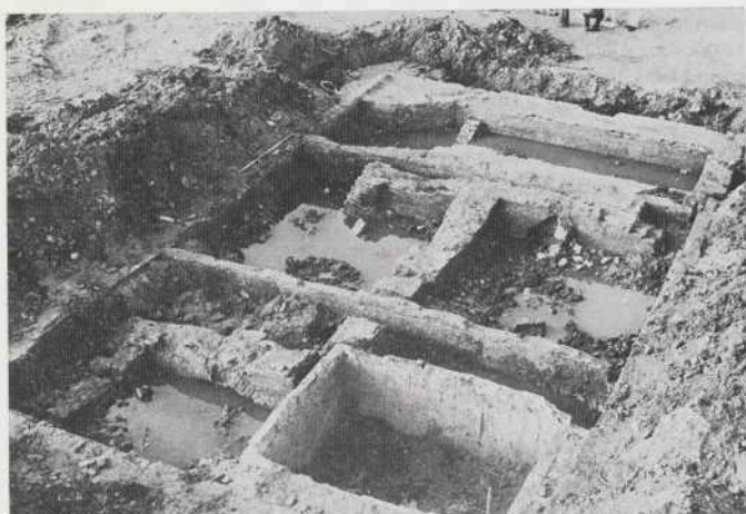
Afb. 14 Purmerend: 't Slot. Muurwerk uit verschillende bouwfasen. Foto ROB.
