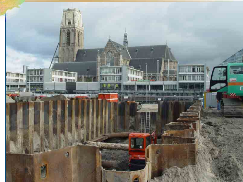
De bouwkuip voor de doorsnede van de dijk met op de achtergrond de Laurenskerk.
