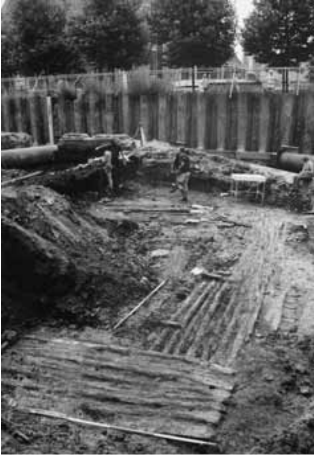
Afb. 61. Rotterdam * Binnenrotte. Houten fundering van 14de-eeuws stenen huis aan de Lombardstraat.
