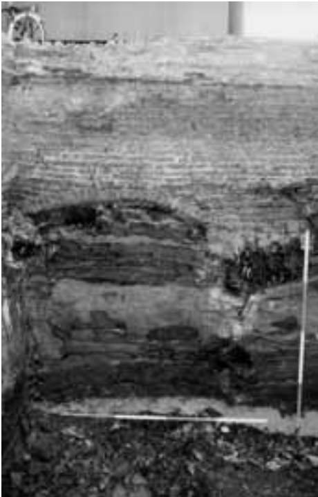
Afb. 26. Hoorn * Grote Noord-Rode Steen. Spaarboogfundering van laat-14de-eeuws ge-bouw achter het huis op het zuidperceel. Boven de fundering zijn drie latere bouwfasen zichtbaar.
