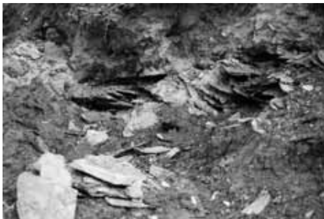
Afb. 20. Heemskerk * Assumburg. Pakket van leien in funderingsleuf (foto: W. Blazer).
