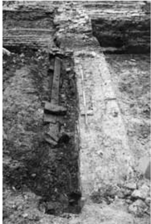
Afb. 24. Hoorn * Grote Noord-Rode Steen. Links fundering van balken behorend bij huis uit circa 1330 op zuidperceel; rechts funderingsmuur van eerste stenen huis uit circa 1400 op noordperceel.
