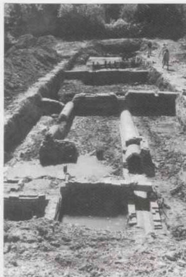
Afb. 22. Hoorn: Karperkuil. Oostelijke kademuur van de doorvaart tussen de Karperkuil en de Kielhaven. Op de foto is de uitgang van het riool in de kademuur zichtbaar. Foto gemeente Hoorn.
