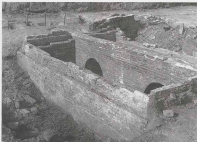
Afb. 25. Texel: Oudeschild-De Schans. Een uit vier compartimenten bestaand waterreservoir. Foto Provincie Noord-Holland.
