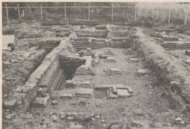
Afb. 34 Rijswijk. Het oostelijk deel van de kerkzaal van de Oud-Katholieke kerk met resten van de altaar-fundering op de voorgrond midden en muurwerk van de pastorie op de achtergrond. Foto Archeologisch Werkverband Rijswijk ZH (R. R. Datema).
