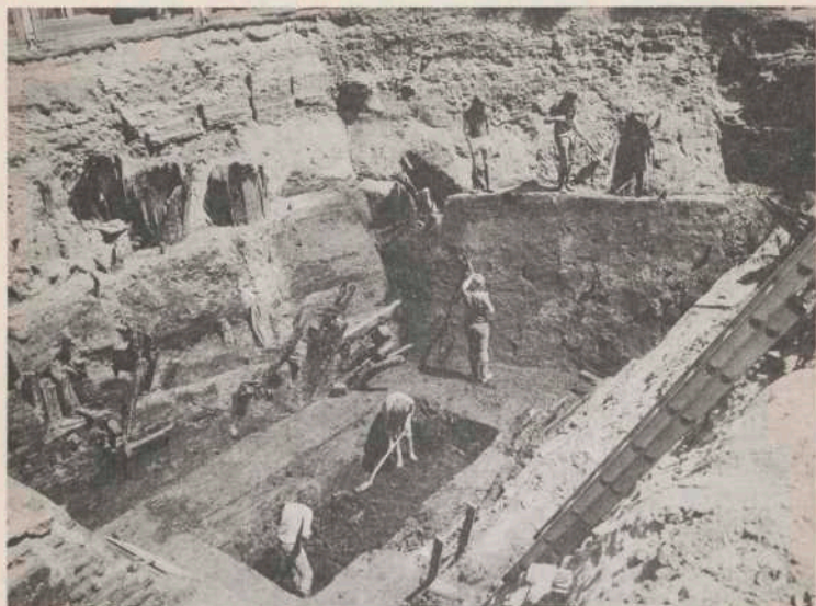
Afb. 29 Dordrecht. De opgravingsput aan de Torenstraat gezien naar het noordoosten. Onder baksteen-funderingen tonnen die als beerput
