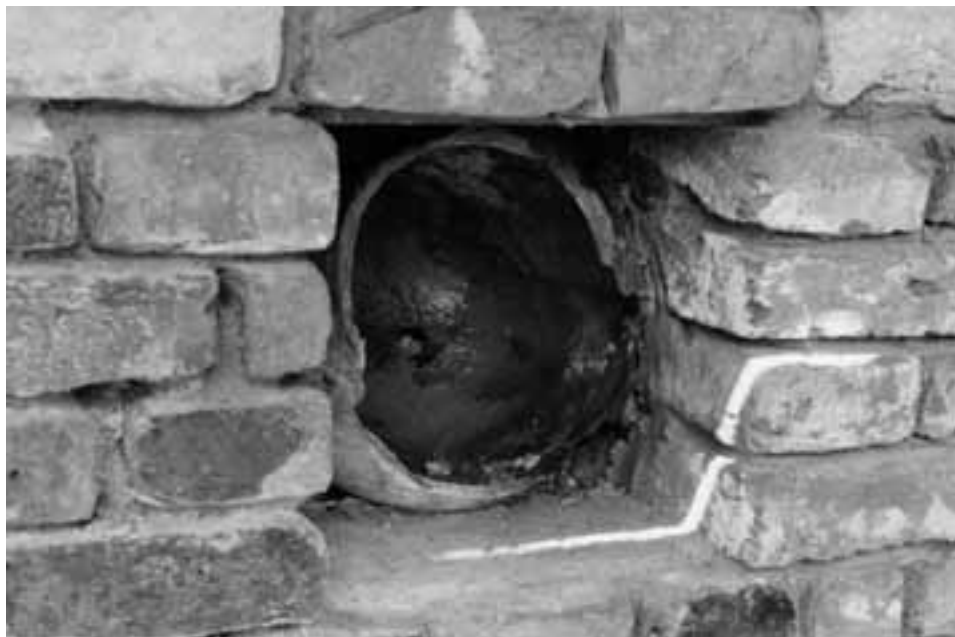
Afb. 18. Enkhuizen * Westerkerk. Eén van de twee aangetroffen nestpotten in de zuidelijke steunberen van de Westerkerk (foto: W. Blazer).
