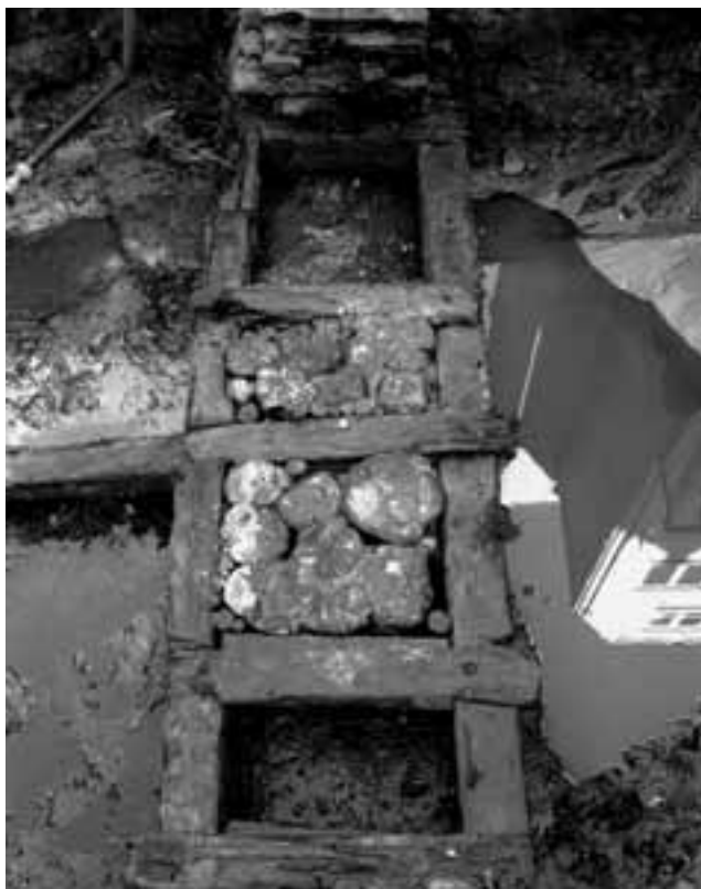
Afb. 10. Amsterdam * Monnikenstraat. Overzicht van een deel van het eikenhouten funderingsrooster met elzenstammetjes van verschillende diameter (foto: W. Krook, Dienst Amsterdam Beheer).
