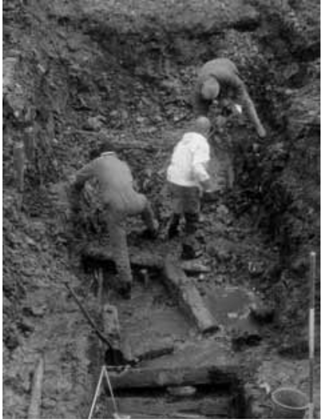
Afb. 13. Amsterdam * Valkenburgerstraat. Vrijgraven van de houten bewapening van het talud (foto: W. Krook, Dienst Amsterdam Beheer).
