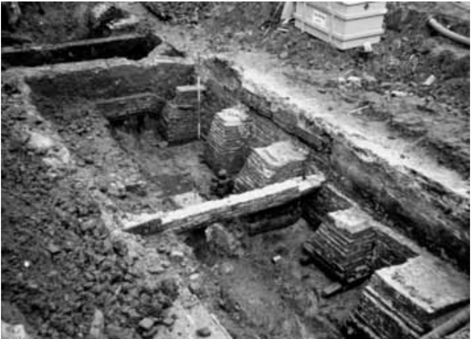
Afb. 6. Amsterdam * Karthuizerstraat. De muur van het klooster met steunberen aan de buitenzijde, gezien naar het noordoosten (foto: W. Krook, Dienst Amsterdam Beheer).
