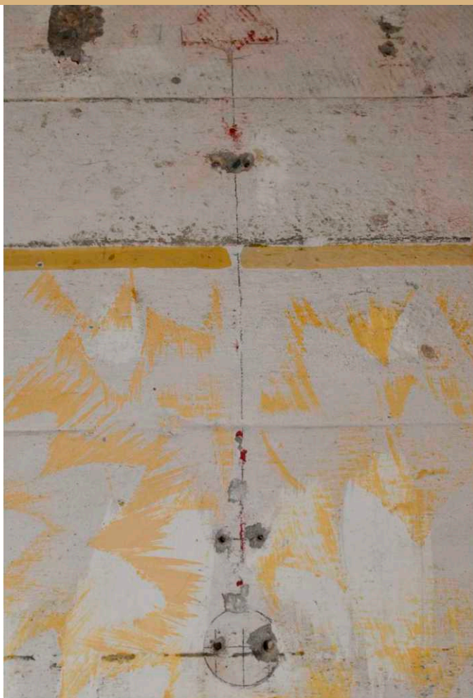
Een van de vele wandschilderingen en bouwbiografische sporen; hier bladeren en met potlood opgetekende planning voor kabels, leidingen en verdeelkasten. (Foto: N. Warmerdam)
