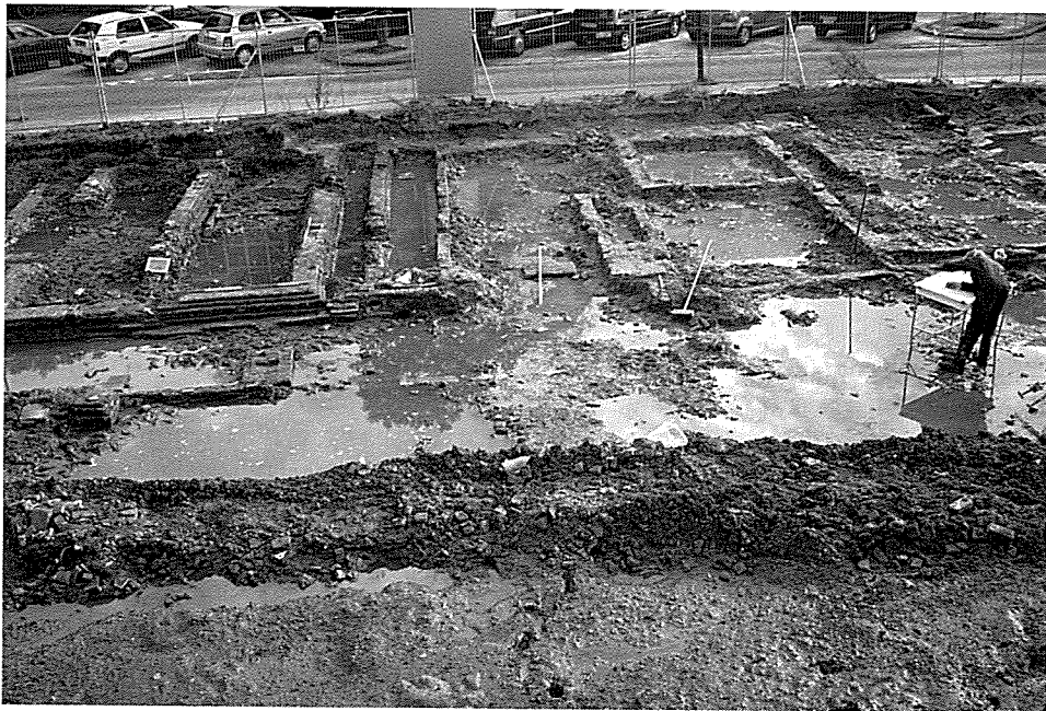
Afb. 59. Gouda * Koningshof. Muurwerk uit de 18de/19de eeuw langs de Raam. Na documentatie worden de muren verwijderd tot op het Archeologisch Peil van 50 cm beneden het huidige maaiveld (foto: B. Silkens, ARC).
