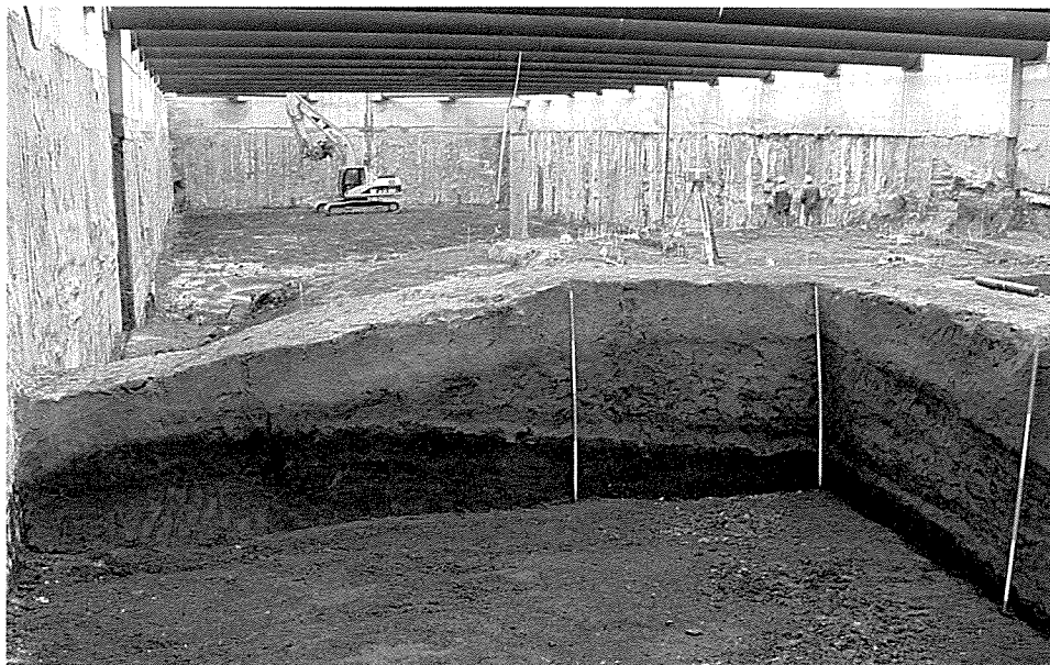
Afb. 72. Rotterdam * Station Blijdorp (RandstadRail). De ligging van de middeleeuwse huisterp midden in de bouwput van het Station Blijdorp.
