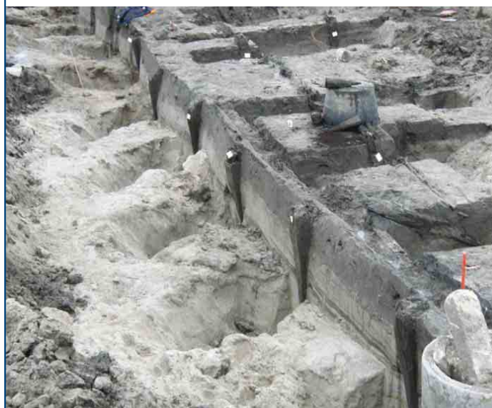
Kadewerken aan de oostzijde van de geul in werkput 2.
