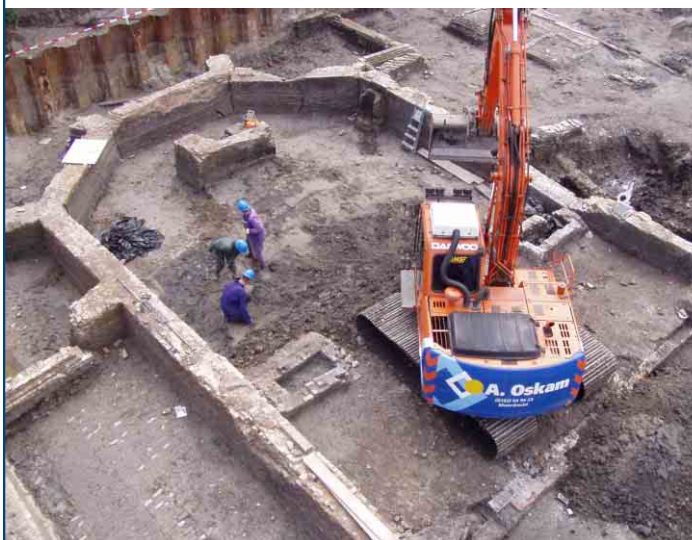
Overzicht van de kapel van het Clarissenklooster,
