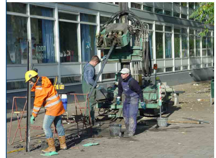
Impressie van het veldwerk door middel van mechanische grondboringen.
