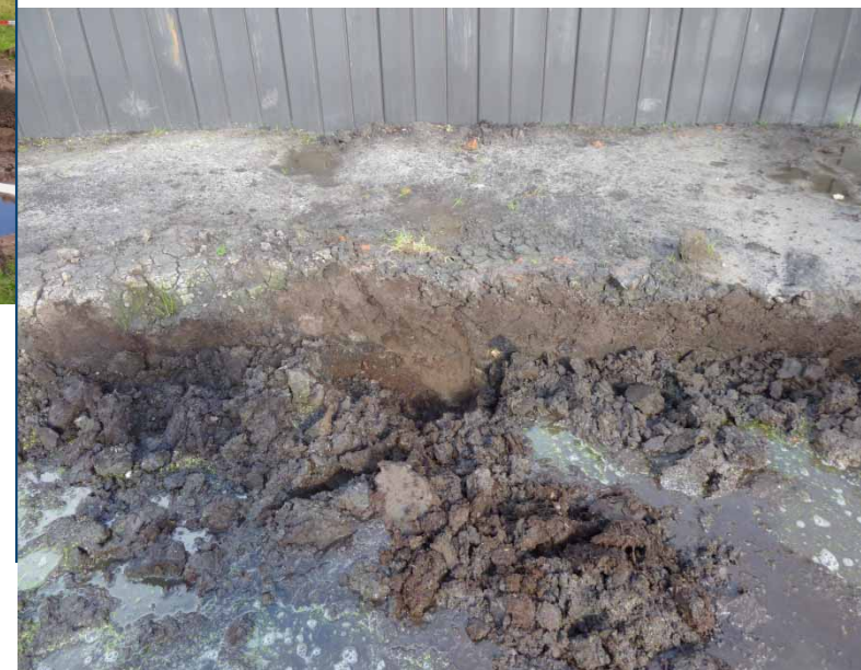
Profiel over de kleiwallen tijdens het uitgraven van de bouwkuip. (Foto: IDDS)
