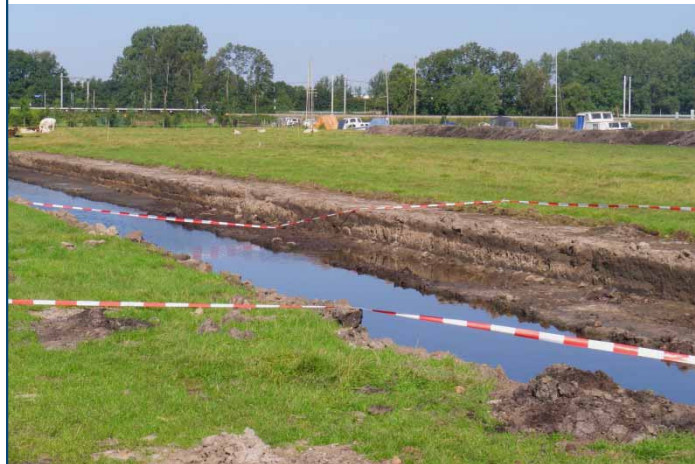
Profiel over de kleiwallen tijdens het uitgraven van de bouwkuip. (Foto: IDDS)
