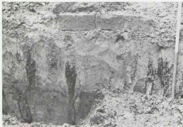
Afb. 18 Alphen aan de Rijn. Het zuidelijke uiteinde van de stenen muur met enkele blokken tufsteen
