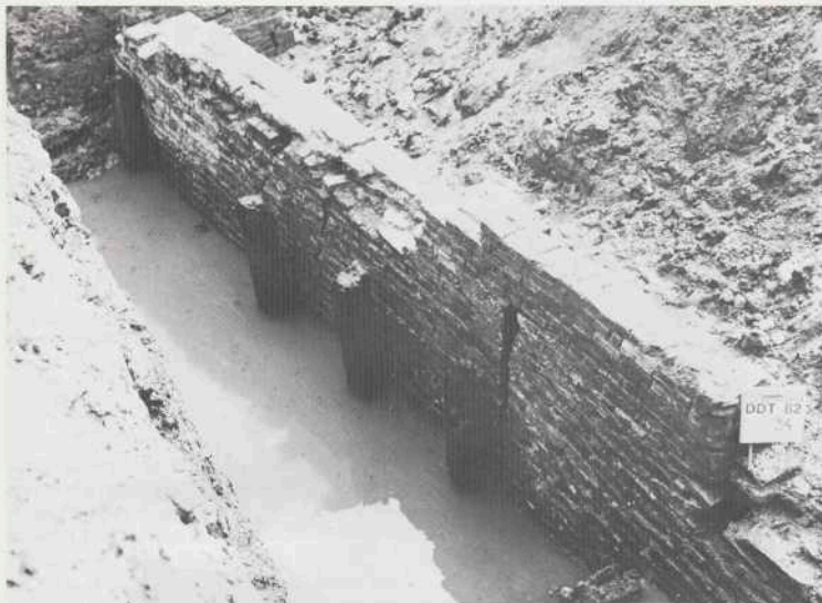
Afb. 17. Dordrecht; Groenmarkt. Kademuur uit het begin van de 14de eeuw met natuurstenen buiten- mantel en stootpalen voor schepen. Foto ROB.
