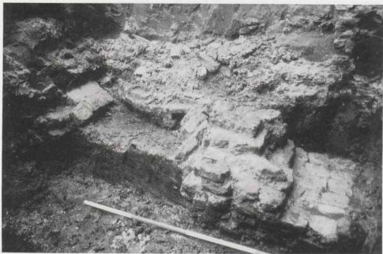
Afb. 8. Alkmaar: Houttil 'Het Waaggebouw'. Stadsmuur uit circa 1280. Zichtbaar zijn een poer en de aanzet van een grondboog. Achter de muur bevindt zich een beerput. Foto: gemeente Alkmaar, afd. Monumentenzorg en Archeologie.
