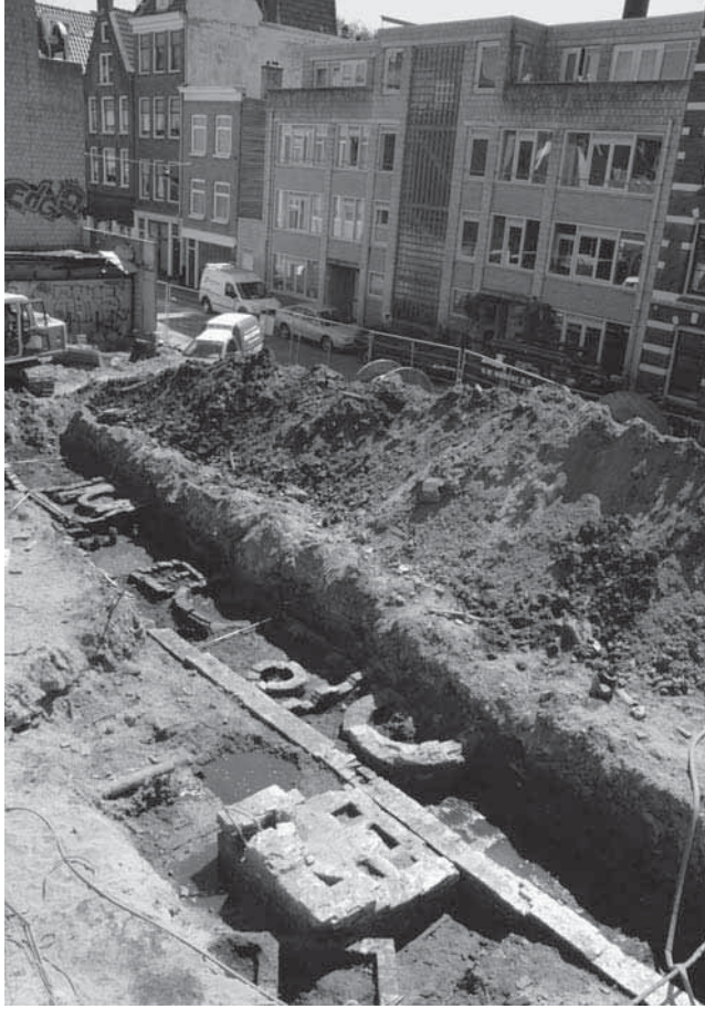
Afb. 12. Amsterdam * Rozenstraat. Overzicht van de verschillende archeologische sporen langs de Rozenstraat. Op de voorgrond de achtergevel van het glashuis aan de Rozengracht met daartegenaan twee ovenstructuren: de fritoven en het uiteinde van de koeloven (foto: Bureau Monumenten en Archeologie, R. Jayasena).
