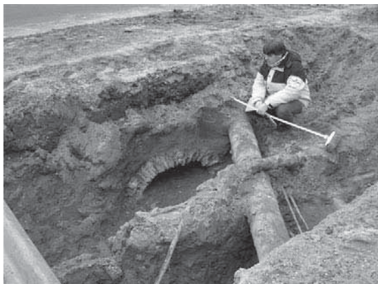
Afb. 17. Beverwijk * Westerhoutplein. Het gewelf in de leidingsleuf (foto: C.E. de Boer).
