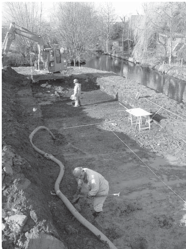
Afb. 56. Gouda en Ouderkerk * Zuidwestelijke Randweg. Aanleg proefsleuf naast Veerstablok 11 te Ouderkerk.
