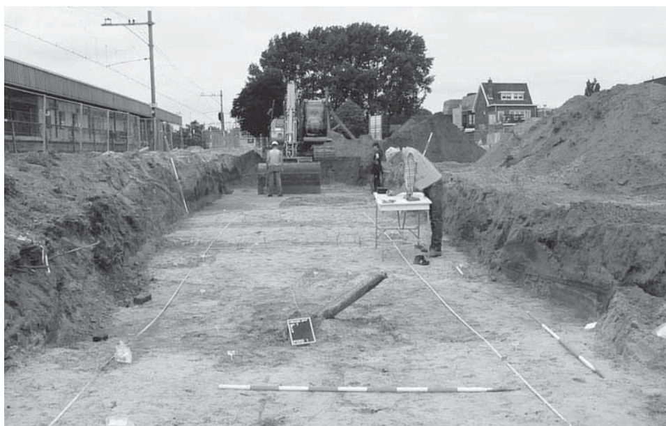
Afb. 27. Heiloo * Stationsplein / De Blincken. De werkzaamheden in volle gang.
