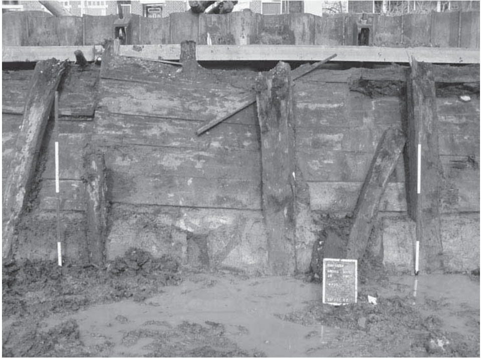
Afb. 21. Enkhuizen * Fruittuinen. Detail van de kadebeschoeiing van de Nieuwe Haven.
