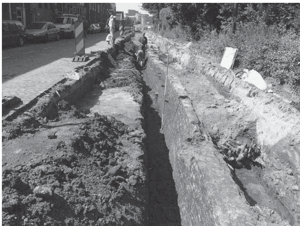
Afb. 6. Alkmaar * Wageweg. De walmuur met de oorlogsschade van 18 september 1573. Van de muur resteert slechts een dunne schil doordat de buitenzijde aan gruis is geschoten, waarna de muurresten van de funderingen af naar buiten zijn geschoven door het gewicht van de aarden wal (foto: Gemeente Alkmaar, afdeling monumentenzorg en archeologie).
