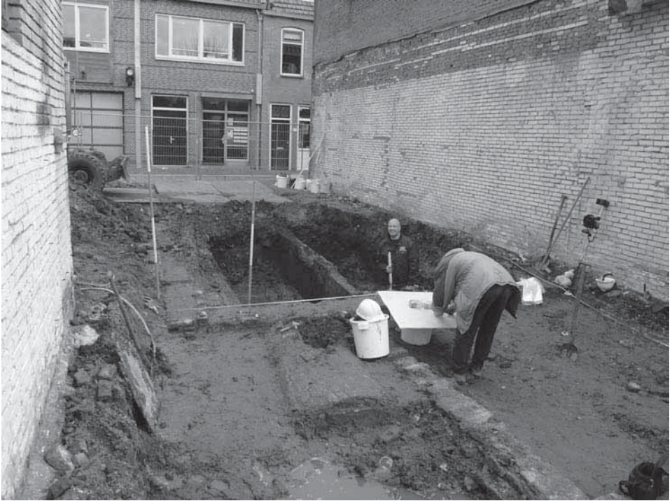
Afb. 1. Alkmaar * Bloemstraat. Vanaf de achterzijde gezien: funderingen van een laat-16de-eeuws huis met aangebouwd versmald achterhuis. In de hoek een overwelfde waterkelder. In de 18de eeuw is het pand voorzien van een grote kelder (foto: Gemeente Alkmaar, afdeling monumentenzorg en archeologie).
