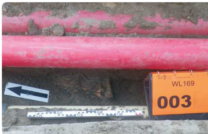
Een skelet tussen de al aanwezige kabels in de leidingsleuf. (Foto: Archeologie Delft)
