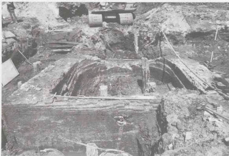
Afb. 17. Hoorn: fundering Geertentoren. Foto Gemeente Hoorn.
