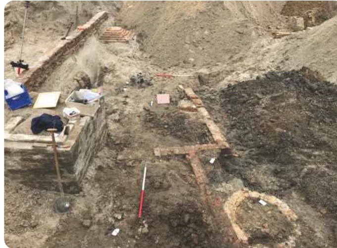
Links muur- en poerfunderingen van het station en rechts de daaronder gelegen muren en een waterput die horen bij de bewoning uit de 15de - 18de eeuw.
