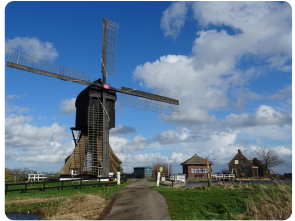
De Westermolen met rechts het gemaal en daarnaast het huis (Foto Ellen Steendam)
