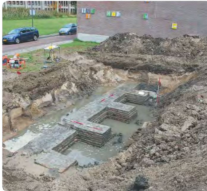
De fundering van de stadsmuur langs de Bagijnenwalstraat en ten oosten van de muurtoren. (Foto's: Hollandia)
