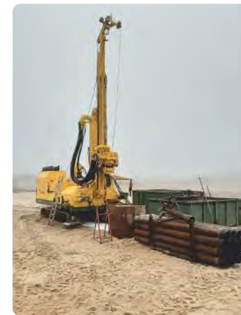
Het boren van de winfilters. (Foto: Antea)
