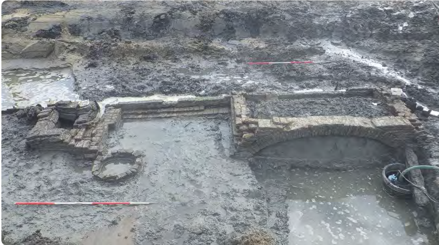
Overzichtsfoto van de funderingen, waterput, beerput en omliggende beschoeide sloot.
