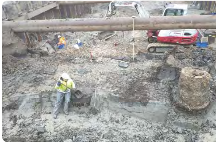
Uitvoering van het veldwerk in de bouwput van het Huis van Delft. (Foto: Archeologie Delft)
