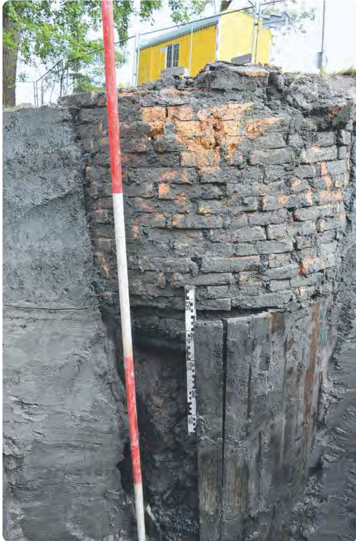
Bakstenen waterput met lattenbeschoeiing geplaatst rond twee houten ringen. (Foto: Vestigia)
