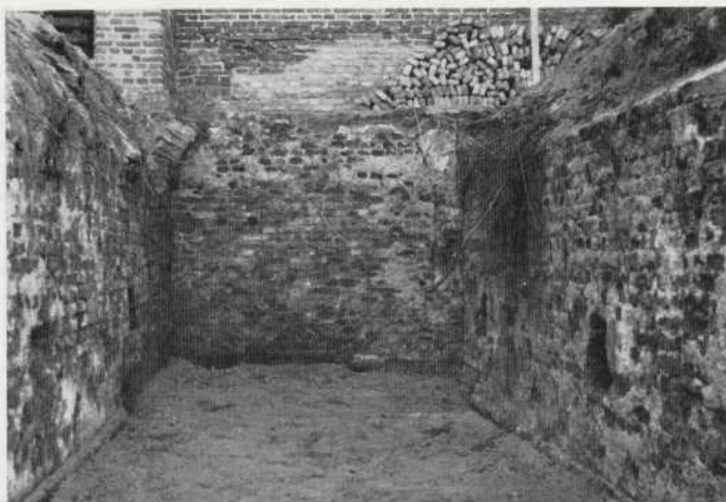
Afb. 36 Warmond. Het zuidelijke uiteinde tegen de kerkmuur van de overwelfde onderaardse verbindinggang met het St. Ursulaklooster; links en rechts lamplissen. Foto P. A. B. Bakkers.
