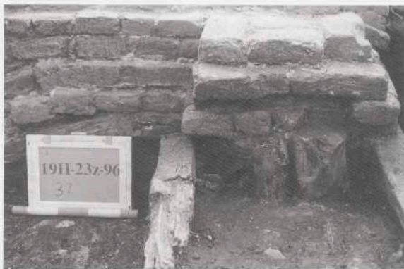
Afb. 17. Edam: Breestraat. Fundering van houten balkjes met slieten uit de 16e eeuw. Foto provincie Noord-Holland.
