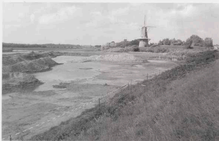
Afb. 23. Gorinchem: Vestingweg. Het blootgelegde oppervlak ter voorbereiding van de dijkverzwaring. De lichter gekleurde delen betreffen de funderingsresten van het kasteel van de Heren van Arkel. Foto ROB.
