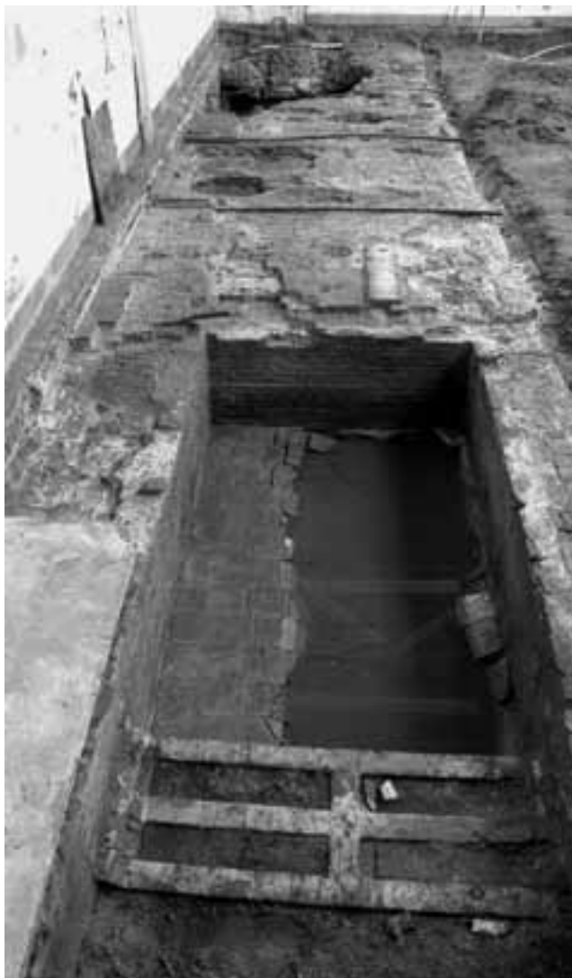
Afb. 10. Amsterdam * Plantage Middenlaan 2 (Hortus Botanicus). De oostelijke helft van de broeikas met de gemetselde gewelven van enkele waterkelders en een bak voor waterplanten op de voorgrond (foto: bureau Monumenten en Archeologie, W. Krook).
