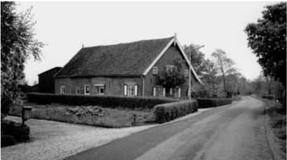
Afb. 55. Groot-Ammers – Goudriaan * Noordzijde 66. De boerderij vóór de sloop (foto: R. van der Giesen).
