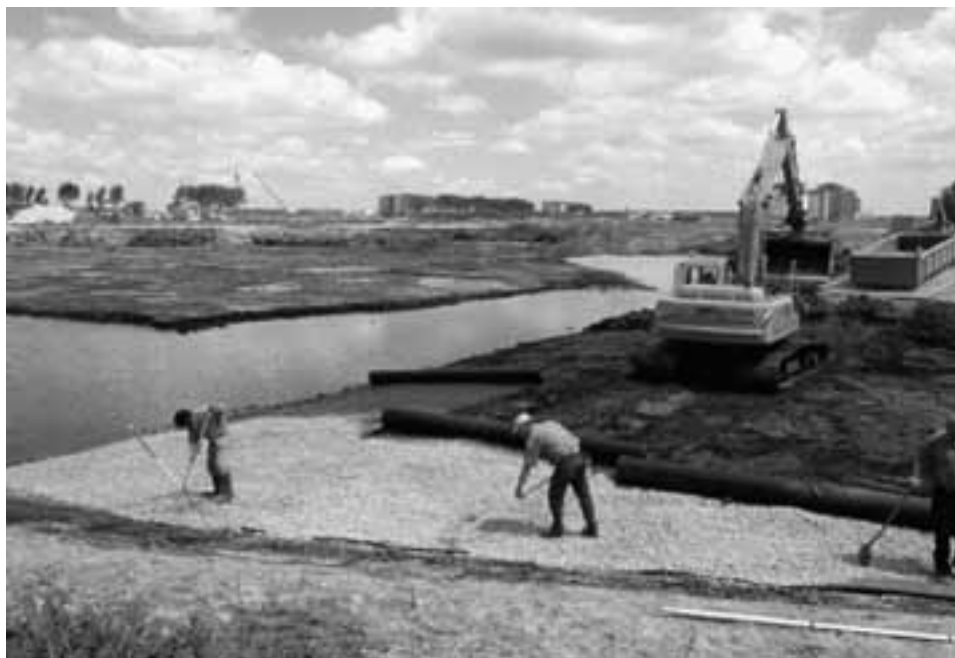
Afb. 47. Barendrecht – Vinex-locatie Midden-IJsselmonde * Gaatkensplas. Aanbrengen van anti-worteldoek en een laag grind ter bescherming van een neolithische vindplaats (foto: BOOR).
