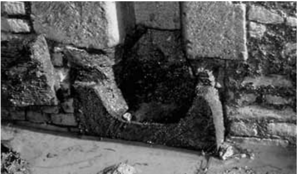
Afb. 64. Schoonhoven * Havenproject. Kademuur ten noordoosten van de brug.
